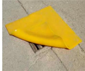
Se refiere a protección de las zonas donde se vierten las corrientes líquidas de baja contaminación al alcantarillado utilizando una rejilla o techumbre que cumple la función del bloquear el paso de elementos que obstruyan las cañerías y ensucien el agua, como hojas o basura.
