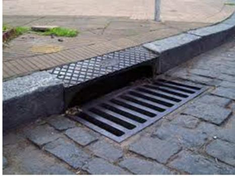
Se refiere a la separación de los sistemas de recogida de aguas lluvias y de las aguas de las distintas actividades. Se pretende separar las aguas de mayor carga contaminante de las de menor carga, a fin de disminuir el volumen de agua a tratar y recircular o redestinar las aguas lluvias a riego o aseo.
